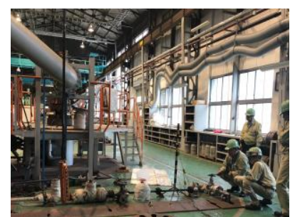
(配管取付機器への性能試験)
